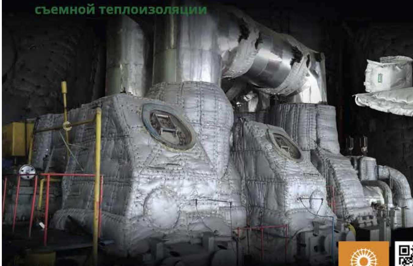
Термочехол на паровую турбину Т-100
